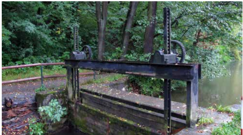
Śluza wodna jeszcze przed remontem.
